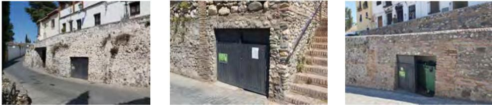
**3.- Adosado/Semiempotrado**, que se disponen, o bien como una construcción adosado totalmente a un muro de contención o fachada de edificio de equipamiento, o bien cuando los muros de contención no tienen mucha altura se disponen empotrados en una parte y sobre saliendo en altura, a modo de mobiliario urbano.
